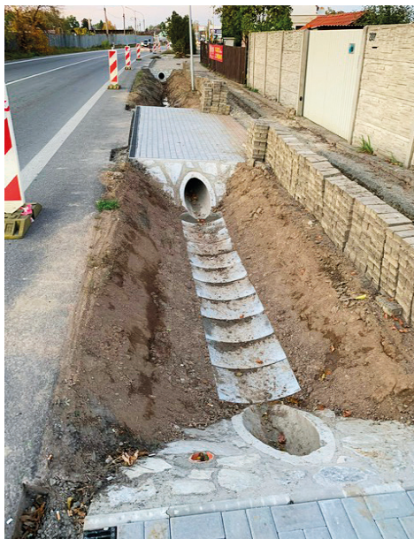
Oprava propustky
